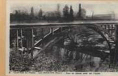
La Pont de la Crémade
